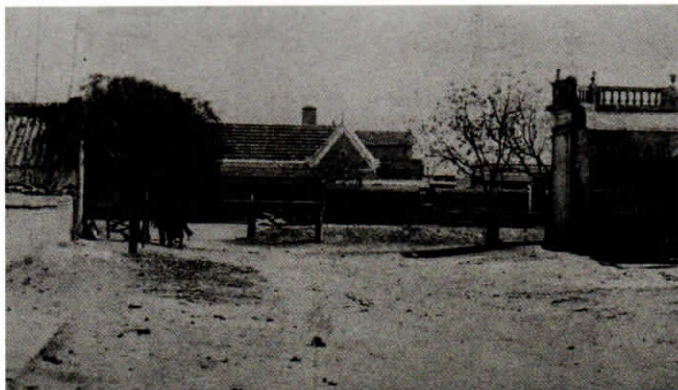
Estación de ferrocarril - Frías
